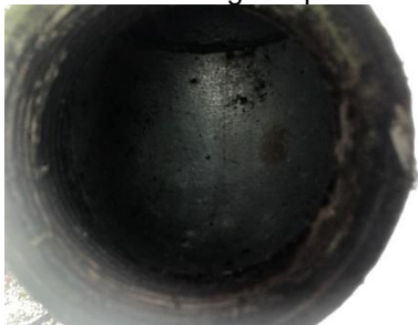
Foto 3 Venstre udluftningsrør på DGU nr. 77.958
